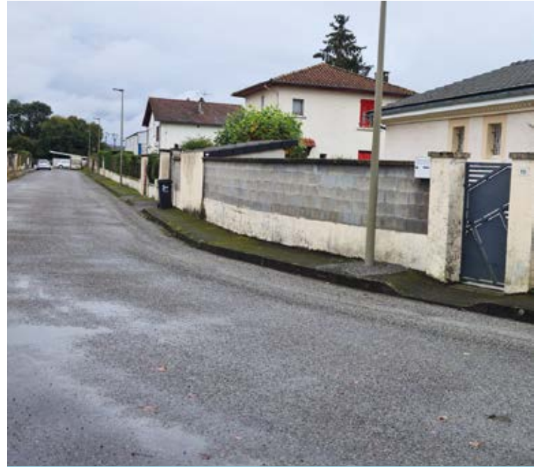
Enfouissement des réseaux rue du Docteur Dulac
