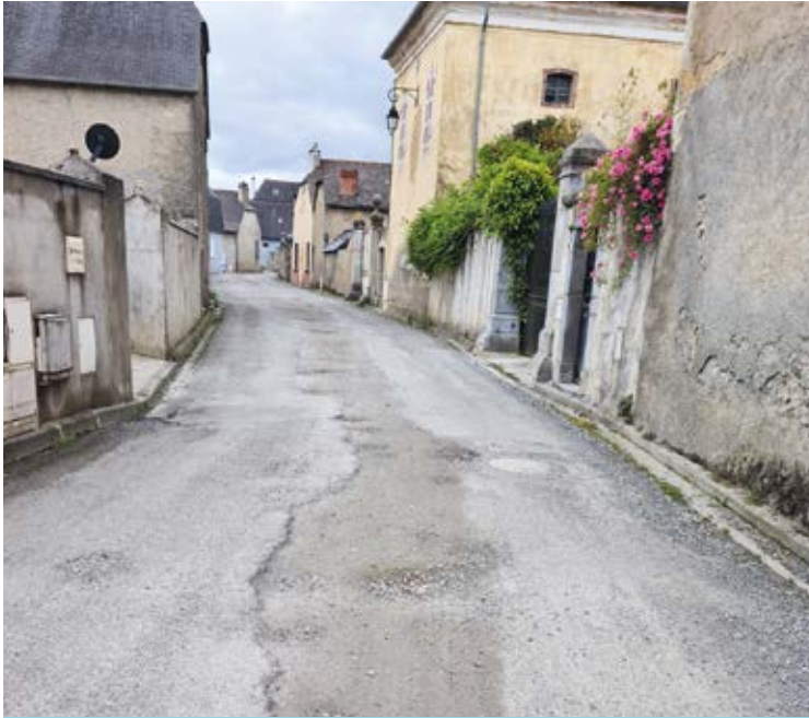
Enfouissement des réseaux rue du 14 juillet
