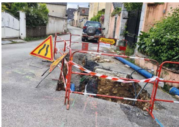
Enfouissement des réseaux rue du 14 juillet
