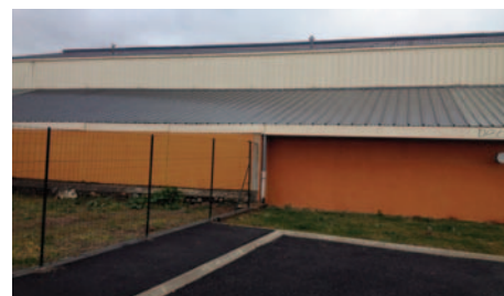
Réfection toiture salle polyvalente
