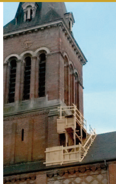
Réparation infiltration église
